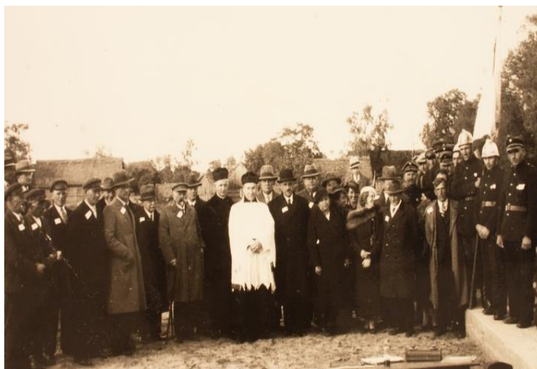
Uroczyste poświęcenie fundamentów pod budowę szkoły
